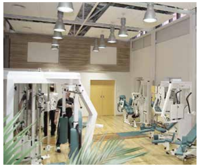
夜间室内不使用的区域，例如：康复中心，用电设备的电源可以集中被切断。
