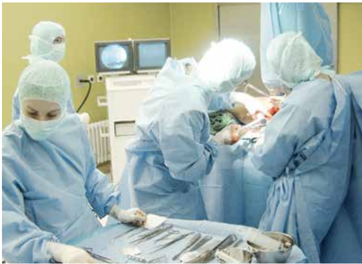
后备电源确保了手术室和监护室内的照明全天候安全工作。
