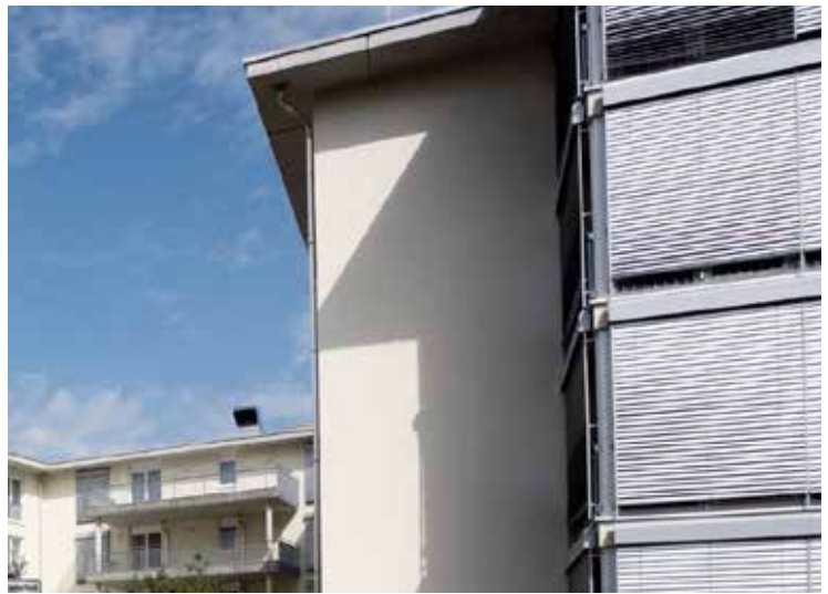
在监护区内自动遮阳控制系统可以提供一个舒适的工作环境，并且避免实验室出现耀眼的太阳光。在开制冷空调的房间，因为有了自动遮阳控制系统，空调不用频繁开启来降低因阳光辐射而升高的室温，从而节省能源。
